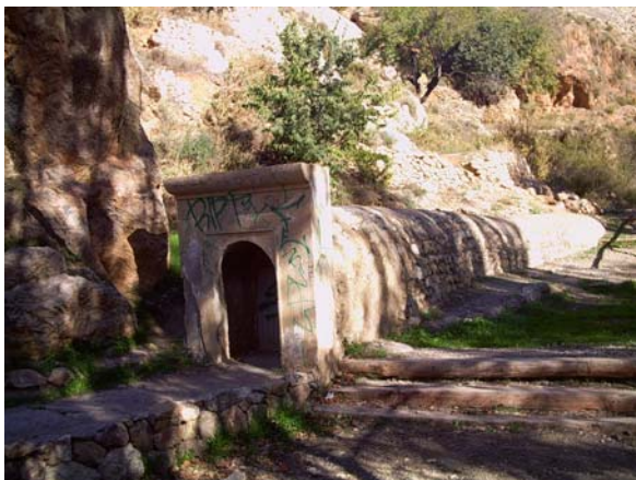
Caseta de mina y acequia (Punto 7 de la fig. 8) (Jorge Jiménez Sánchez)
